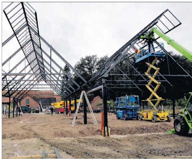
Es wird emsig gebaut: Gäste der „Tage der Gartenkultur“ können auch die entstehende Orangerie (600 qm) ansehen.
